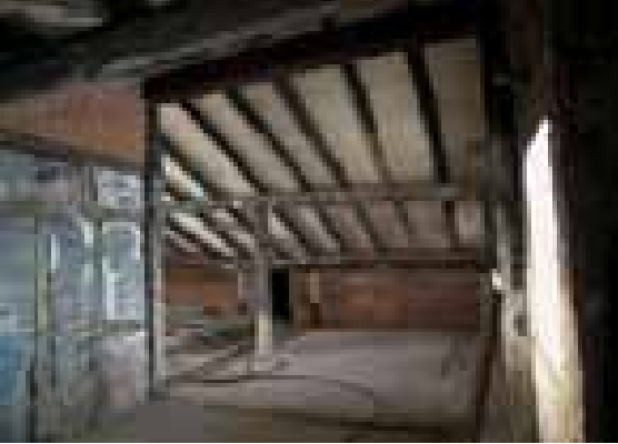
Heute zeitgemäß zu Bewohnen, das freigestellte und repariert Dachgeschoss
