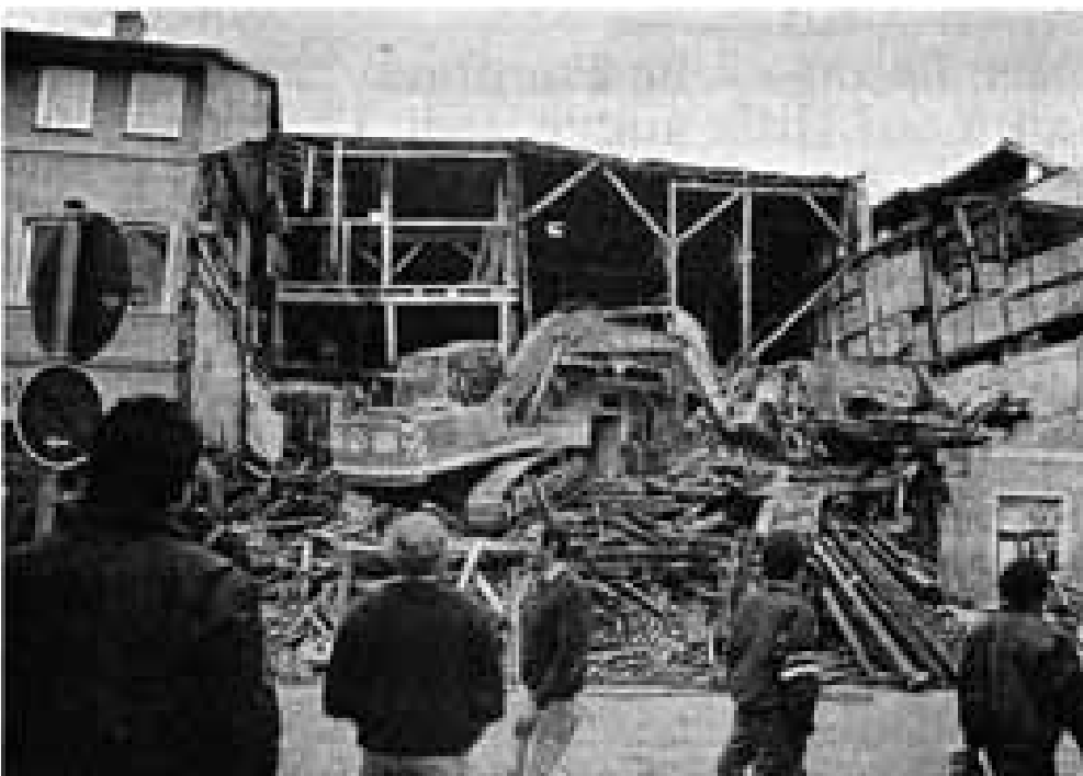
Bei Montag räumen Bagger in der Westendstraße und stürzen den Restschutt der letzten Häuser Nummer 23 und 24 weg. Die Baubüchse soll mit einem neuen Kämpfer gefüllt werden, der nach Wohnungen sucht.
