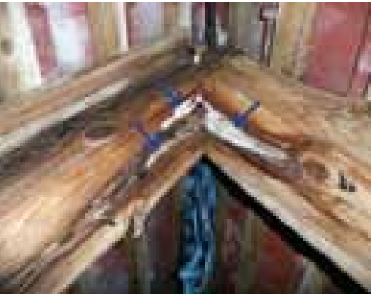
Bild 9 Fruchtkörper (Pfeile) des Flaumigen Rindenpilzes auf der Unterseite eines Sparrenkopfpaares
