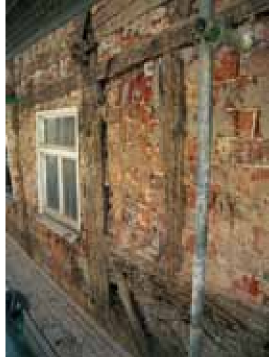
Bauzeitliches Fachwerk an der Osttraufe von 1366/67 (d) mit Resten von Lehmflechtwerk
